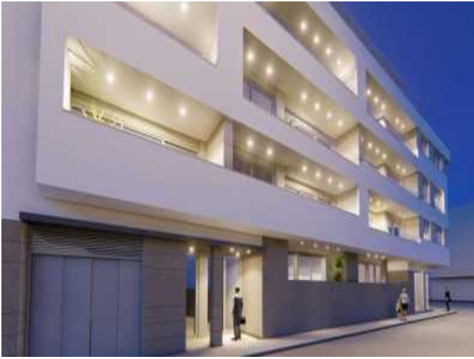
VIVIENDA 6 La vista desde arriba
